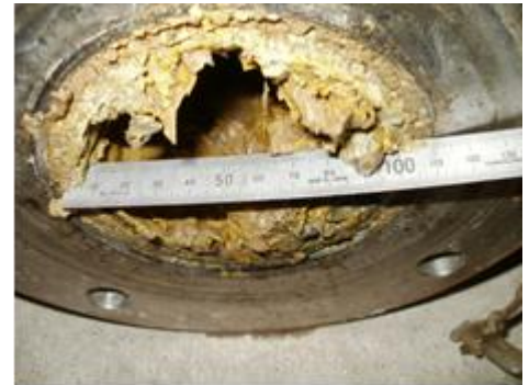
写真-1 ポンプ吸い込み部分の状況
